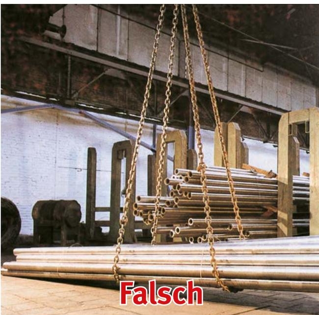
Bild 5-18: Derart lange Lasten dürfen nicht an nur einer Kette – selbst im Schnürgang – angehängt werden
