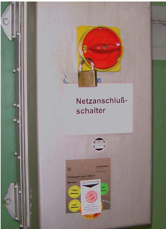
Bild 7-2: Der Kranführer schaltet den Netzanschlussschalter aus
