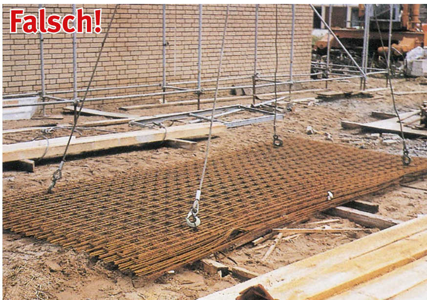
Bild 16-5: Einhängen in die Umschnürung ist lebensgefährlich!
