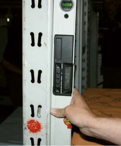
Abb. 10 Messung der Schiefstellung mit digitaler Wasserwaage
