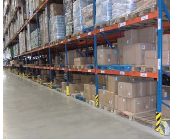
Abb. 19 Stützenschutz an allen Stützen
